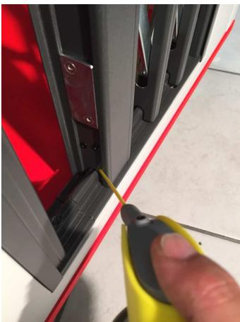
Lubrificare con **SPRAY SILICONICO** il binario inferiore.
