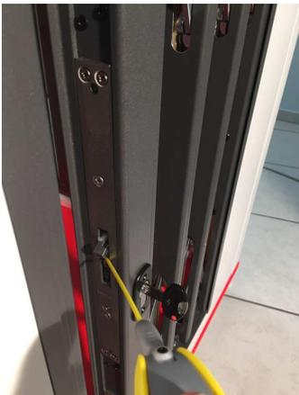
Lubrificare con **SPRAY SILICONICO** la serratura ed il cilindro di sicurezza.
