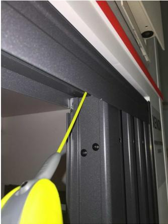
Lubrificare con **SPRAY SILICONICO** i carrelli di scorrimento e il binario superiore.
