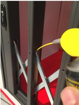
Lubrificare con **SPRAY SILICONICO** le leve di collegamento e i loro perni di movimento.
