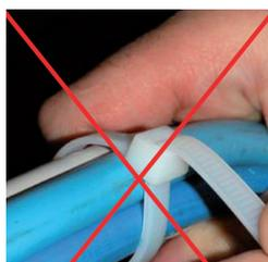
Evitare di flettere la fascetta formando un angolo nel senso inverso del serraggio: tale operazione non consente un corretto fissaggio dei cavi
