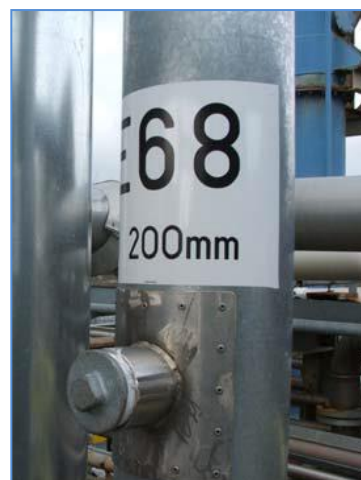
Figura 1 - Esempio di bocchettone di campionamento
